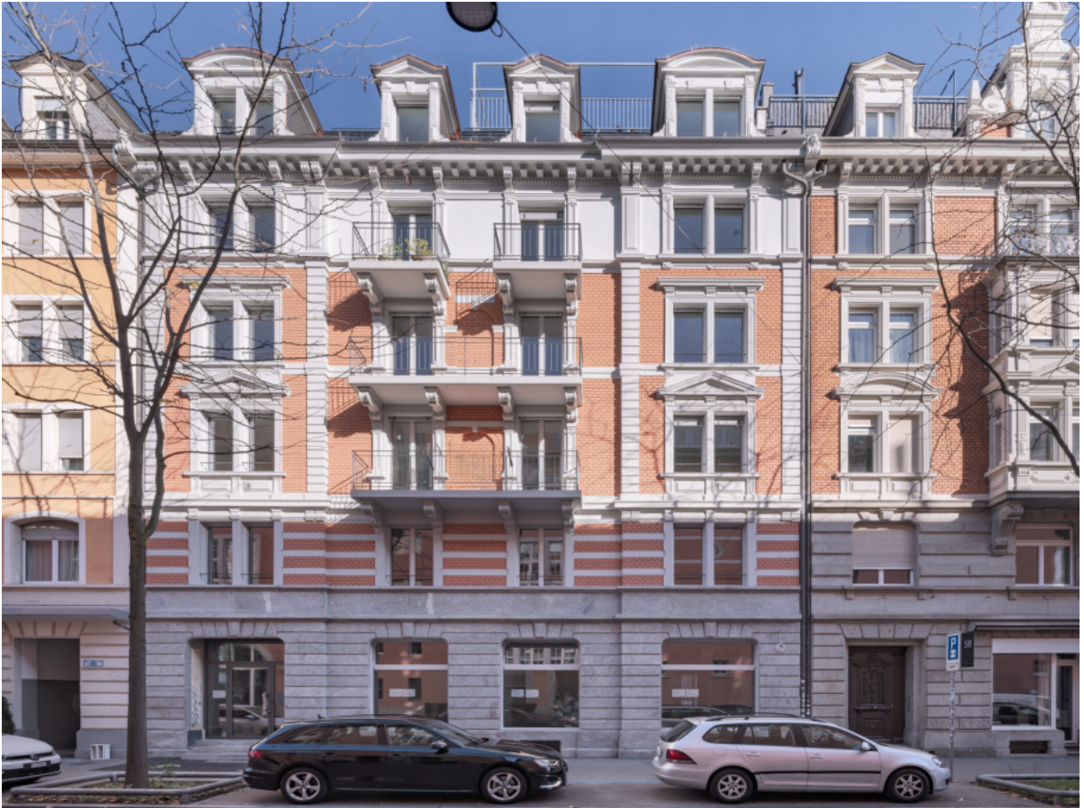
Umbau Mehrfamilienhaus Bäckerstrasse in Zürich
